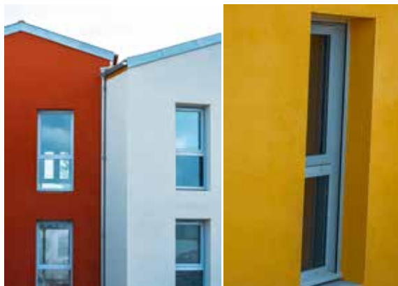
Architecte : Aerts & Planas
